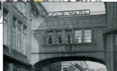
Station 8 Rolingswerth: In Europa beinahe die erste „Elektrische Zentralanlage“
