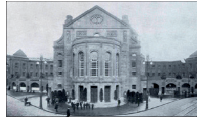
Station 18 Opernhaus: Kronjuwel der 50er-Jahre-Architektur und Theater für Wuppertal
